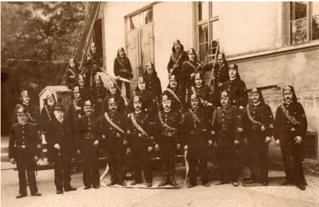
Steigerabteilung der Freiwilligen Feuerwehr Olvenstedt (Olvenstedt ist heute ein Stadtteil von Magdeburg)
