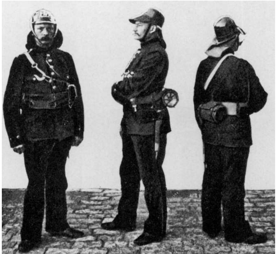
Tragart der Rettungsleine mit Schmals-Rettungsbremse
